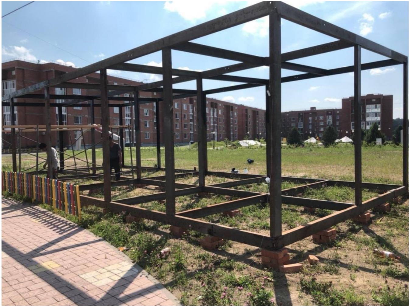
Рисунок В. 22 – фото строительного процесса в Заречном сельском поселении
