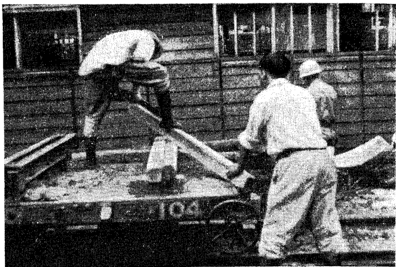
Подсобные рабочие на узкоколейке энергетического комплекса Куроба
