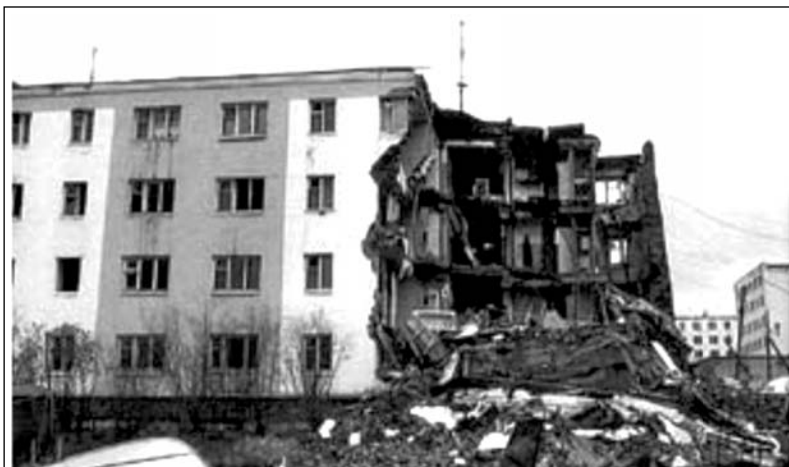
Рис. 1. Из-за глобального потепления подтаяла вечная мерзлота и грунт не выдержал тяжести здания в российском городе Воркута (Моисеенко, 2007).
