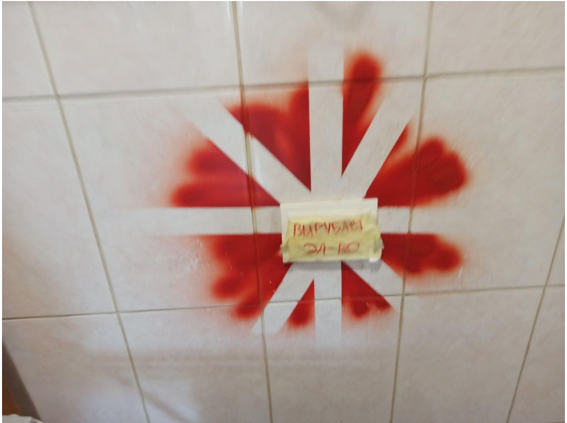
Рис. 55. Объявление, наклеенное на розетку в одном из санузлов ДОма
