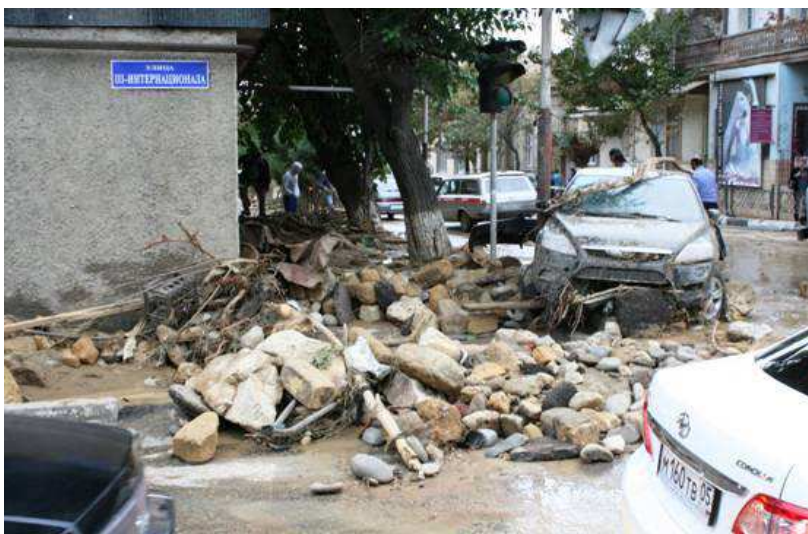
Фото 16. Дербент. Последствия селевого потока.
