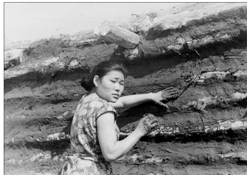
Девушка в процессе строительства дома. 1960-е гг. Фото из архива Ю.Б. Симченко.
