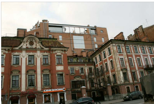
Рис. 4. Написано "Связной", но меж домов нет связи, А только ком архитектурной грязи (Н. Потапова).
